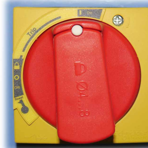
Joon. 34: pealüliti sisselülitamine
